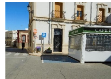
Ejemplo de aparcamiento en línea para PMR
