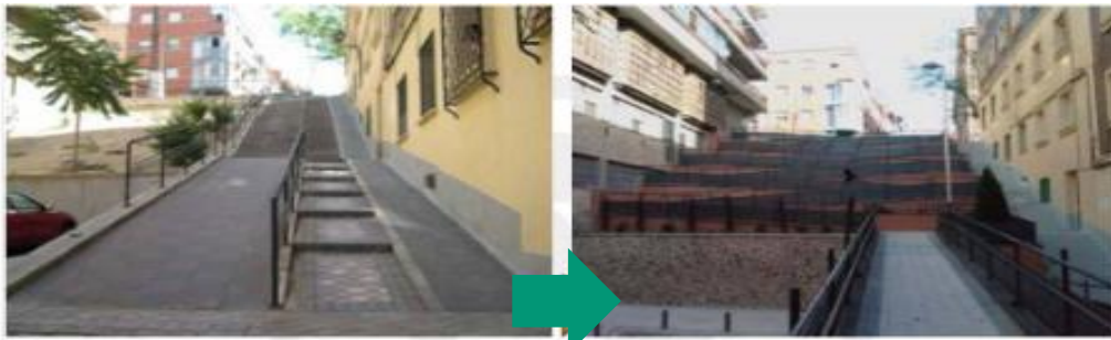
Ilustración 61. Supresión de barreras arquitectónicas y rampa de pendiente excesiva en Plaza Bami de Madrid. Fuente: Diseño para todos
