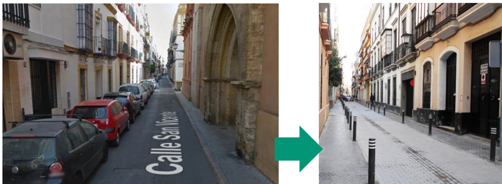
Ilustración 65. Transformación de sección de la calzada en plataforma única. C/San Vicente (Sevilla). Fuente: Elaboración propia.
